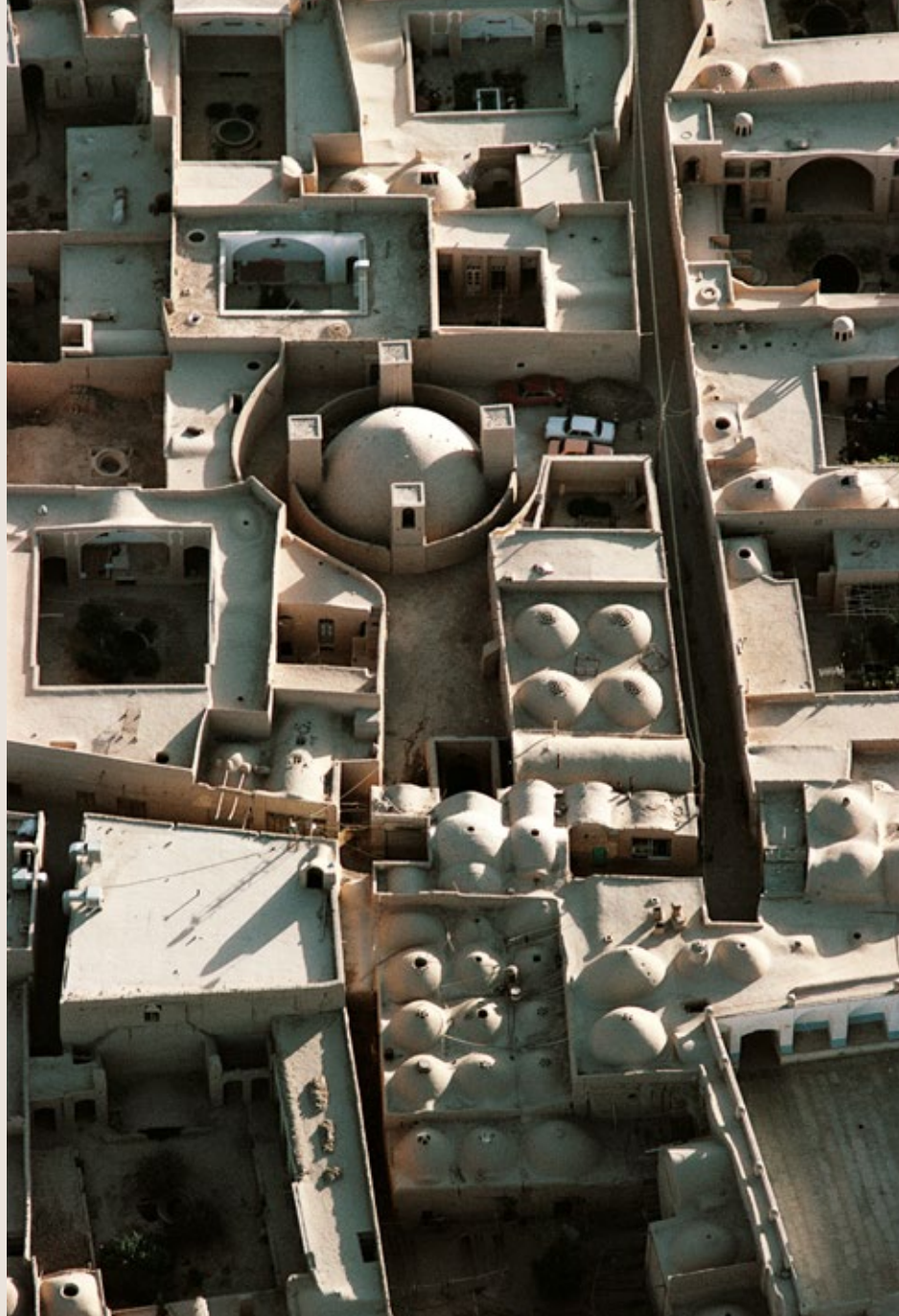
↑ Yazd, Iran Domy kopułowe ze zbiornikiem na wodę deszczową i wieżami wiatrowymi.
